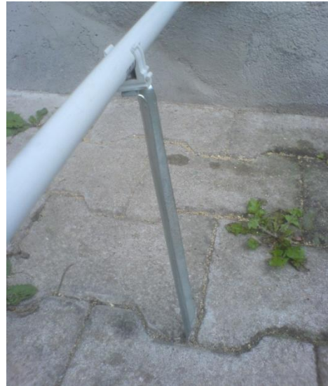
Abbildung 7: Erdhering mit Rohrschelle und Elektroinstallationsrohr
